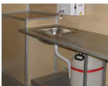
Мойка, фляга для воды. Выгородка для газовых баллонов
