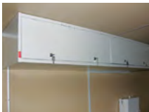
Шкаф для хранения и перевозки бытового инвентаря, посуды и продуктов питания размещен над мойкой с водонагревателем
